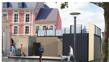
L'installation des trois bâtiments modulaires doit se faire cette semaine.
